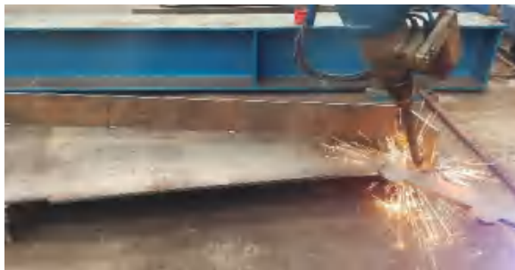
（规则焊缝焊接）
