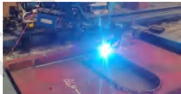
（异形焊缝焊接）
